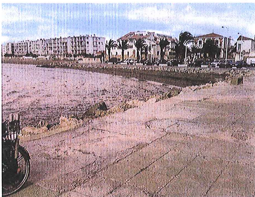
Secteur au pied du parking de la villa Pary ou sera aménagé provisoirement la piste de 6 m de large pour l'évolution des tombereaux
